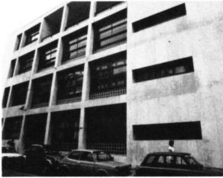
37 Casa del Fascio, Como, Via Pessina facade, detail
